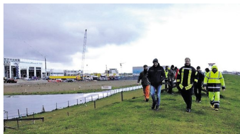
In jedem Frühjahr überprüft eine Kommission, ob es gravierende Schäden am Elbdeich zwischen Belum und Cuxhaven (im Hintergrund sieht man das Siemens-Werk in Cuxhaven ) gibt.
