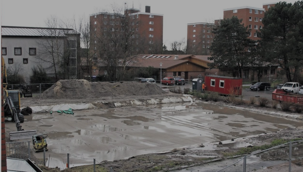
Nein, es wird nicht das Lehrschwimmbekken: Hier soll einmal die Mensa der Süderwischschule stehen.
