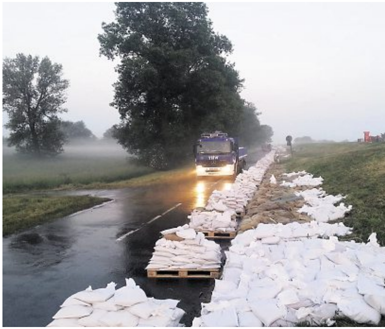
Deichentlastung und die Verlegung des Schutzes zählten zu den wichtigsten Aufgaben der THW-Kräfte. Foto: red
