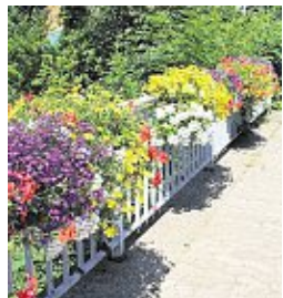
Schön, aber sehr pflegeaufwendig: Die Balkonkästen an der Brücke der Wohlensstraße.
