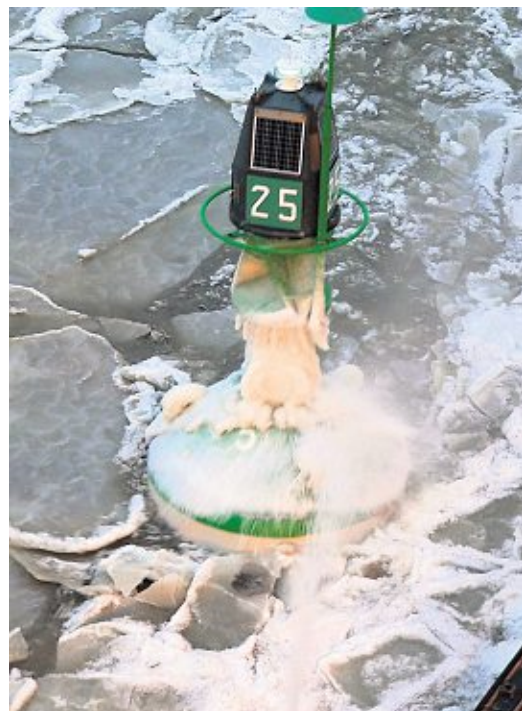
Solange der Aufwand vertretbar ist, wird versucht, den Eispanzer an den Tonnen mit heißem Wasserdampf zu knacken. Fotos (3): WSA Cuxhaven
