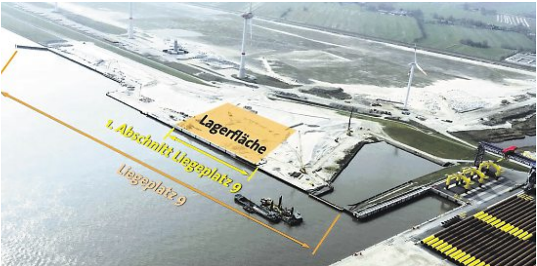
Heute wird am bereits fertiggestellten Liegeplatz für Massengutschiffe (1. Abschnitt) am Liegeplatz 9 das erste Schiff erwartet. Es ist die „Bulknes“ der Reederei Hartmann (Mibau). Sie bringt Mineralgemisch, mit dem die dazugehörige Lagerfläche befestigt werden wird. In den kommenden Wochen werden dort mehrere große Massengutschiffe Granitsteine für die Wasserbaustelle beim Glameyer Stack löschen. Foto: Scheer/ Grafik: Franke
